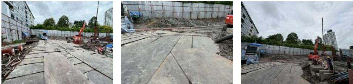
รูปที่ 2.2-13 สภาพถนนภายในพื้นที่ก่อสร้าง และการปูแผ่นเหล็ก
